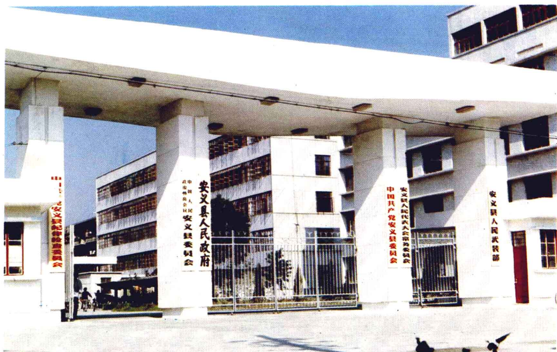
● 安义县党政机关办公楼
