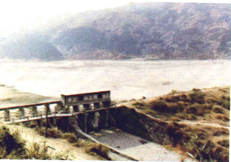
● 解放后的第一座水库——礼源角水库
