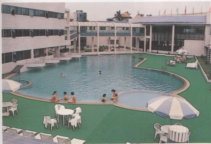
▲兴隆温泉宾馆的温泉游泳池
