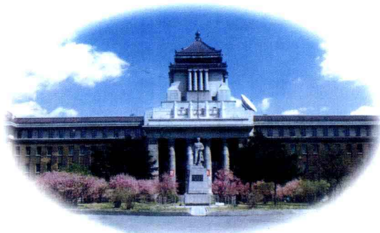
吉林大学新民校区基础楼
