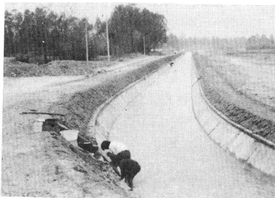
▶高州县石鼓 镇防渗支渠 立贺 华琼摄
