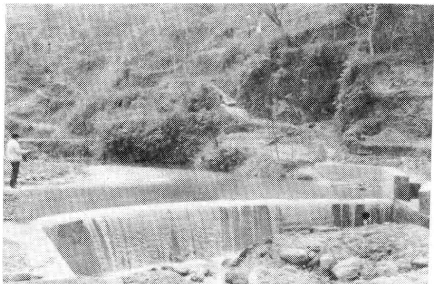
◀近年来,高州县把木石陂改造作为水利建设的主攻方向之一。仅1991年度就改造或新建混凝土永久性水陂226宗。图为马贵镇堤垌陂。
