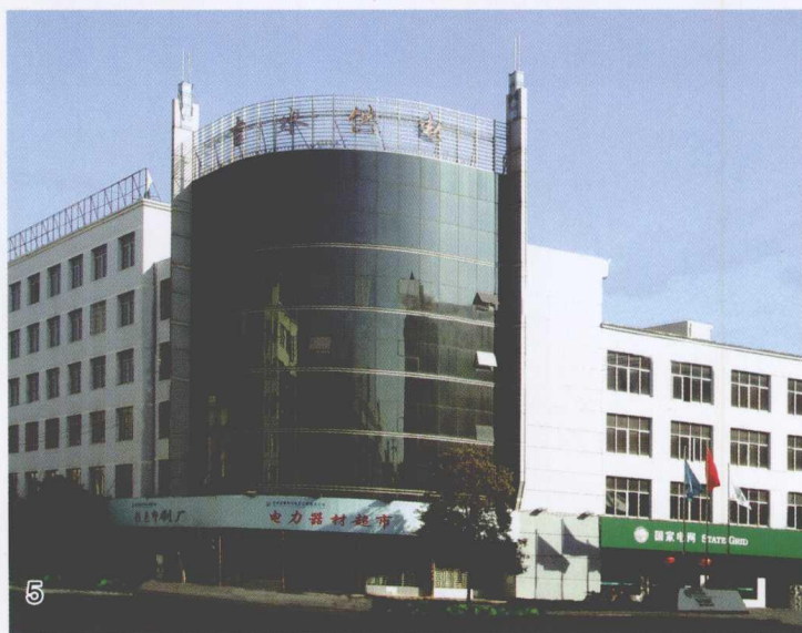
1、2 县委机关 3、4 县人大机关 5 供电大楼 6 信用合作社大楼
