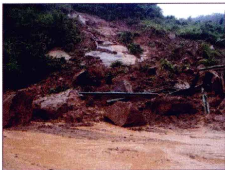
岩质滑坡 (渝黔高速公路, 中国新闻网)
