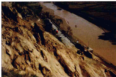
2007 年 10 月 24 日凌晨 1 点，G307 线子洲段 K913+800 处发生特大土质崩塌（20 多万立方米），造成交通中断（陕西，榆林公路管理局）
