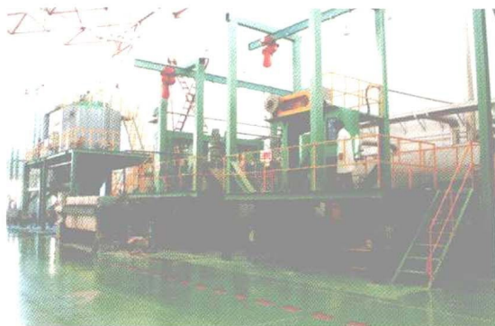
内蒙古和发稀土公司稀土生产车间
