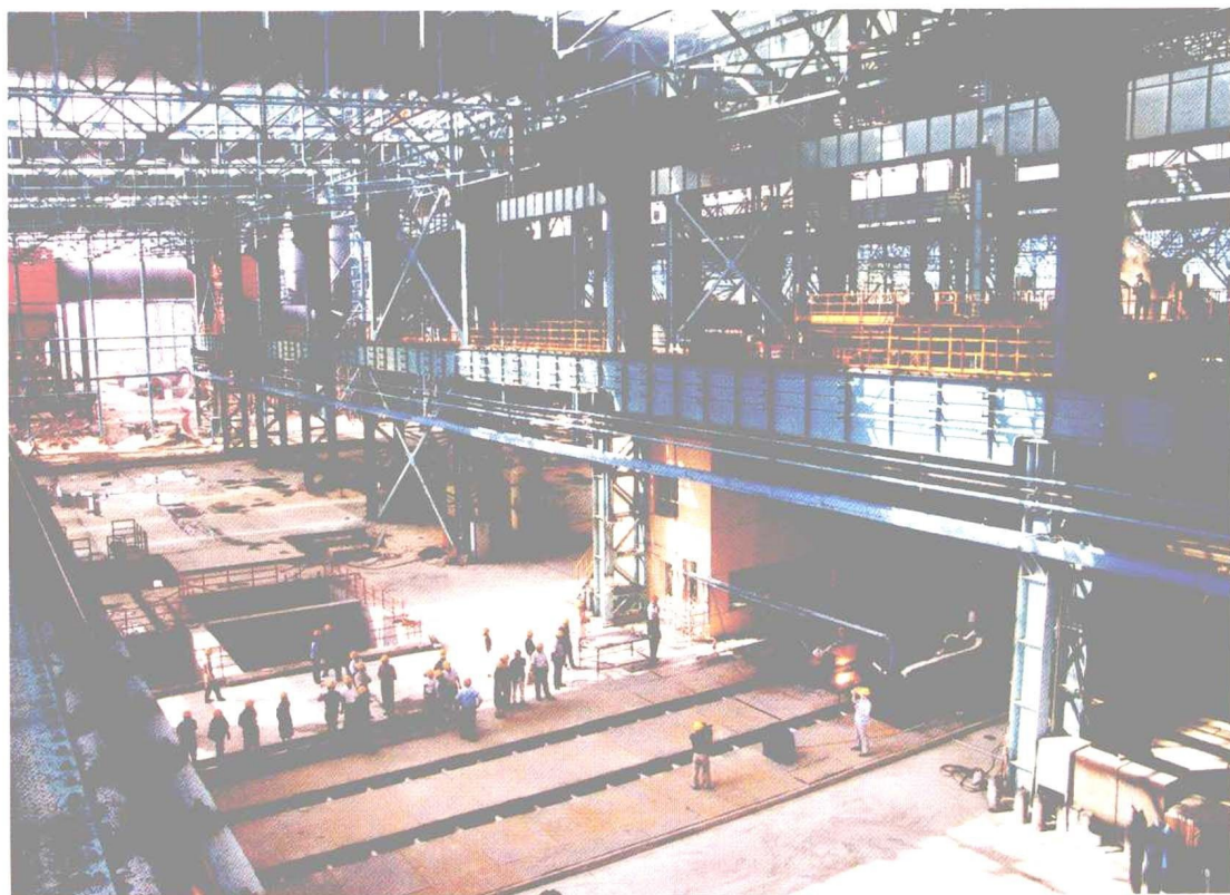
华业特钢不锈钢项目生产现场
