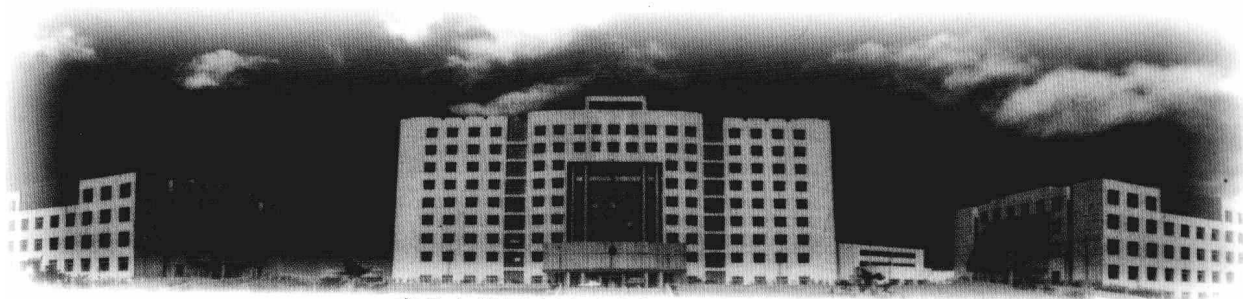
南昌市郊区人民政府机关办公大楼全景
