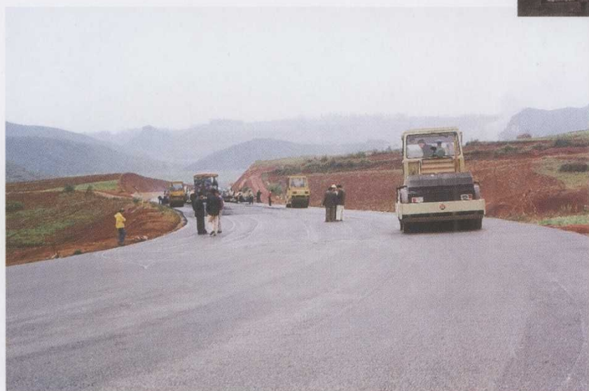
砚山至文山二级公路路面施工现场
