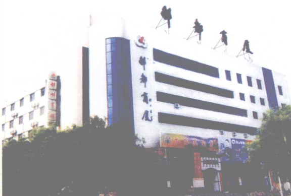
县供销社自筹资金兴建的综合大楼
