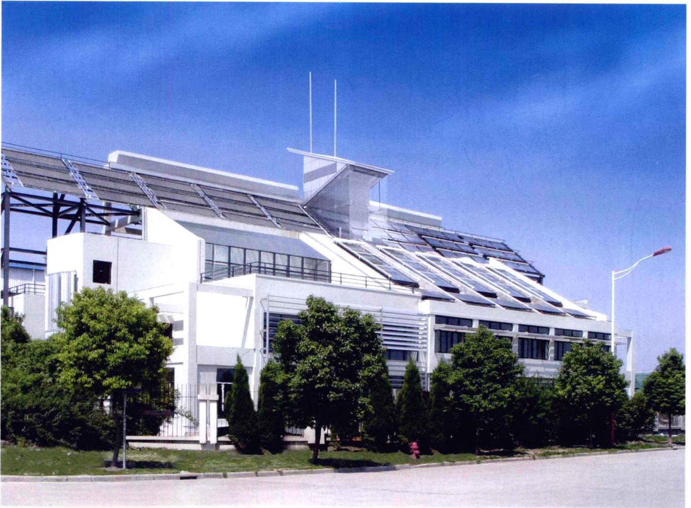
图 2-1 上海生态办公示范楼实景图
