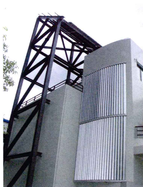
图 2-6 西立面遮阳系统实景
