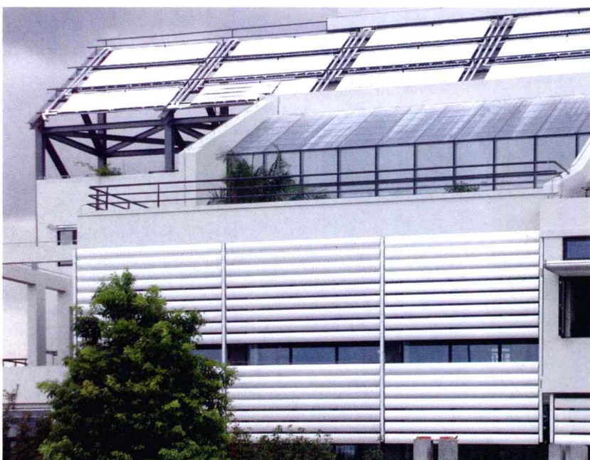
图 2-5 天窗遮阳系统实景
