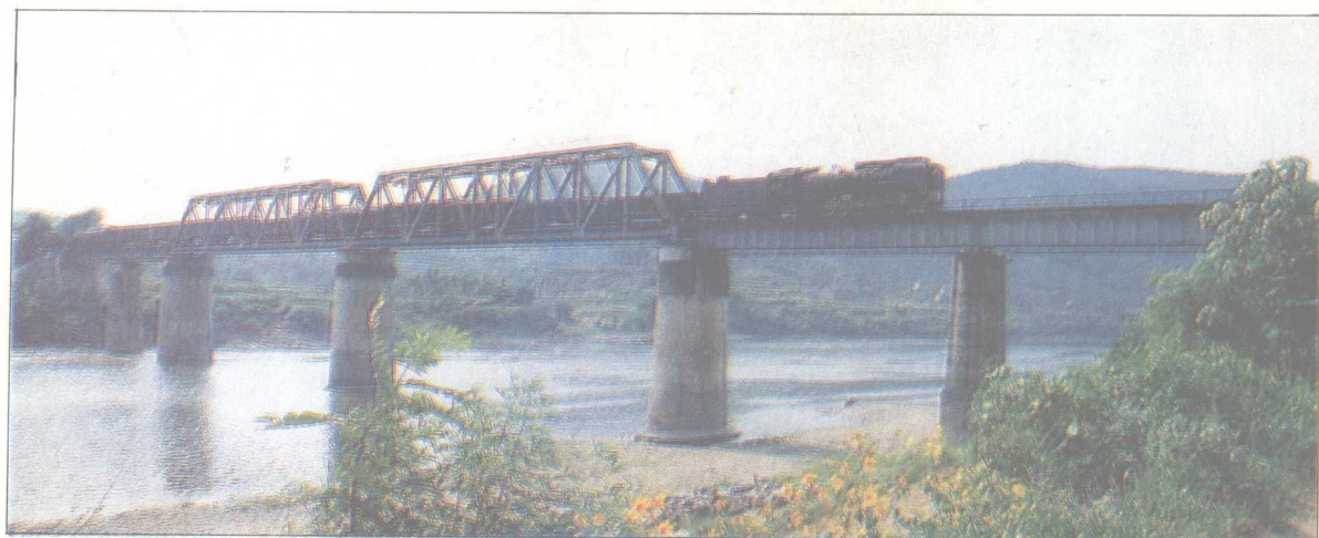
资江渣洋滩铁路桥
