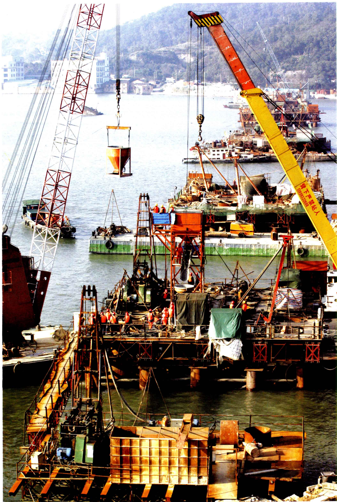
福厦铁路乌龙江特大桥正在紧张施工中
