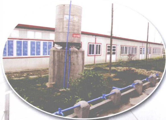
▲ 德阳汉旺中学自制水塔解决板房校区实验课用水问题
