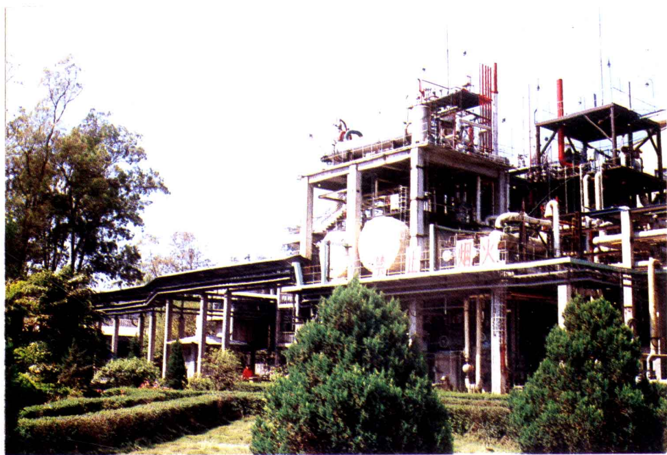
福州第二化工厂聚氯乙烯高型号生产装置
