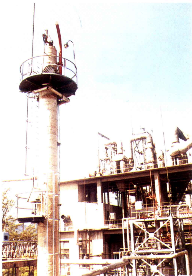
福州第二化工厂聚氯乙烯车间一角
