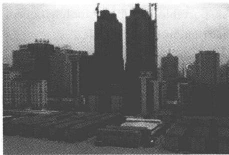
(b) 深圳华润万象城工程工地
