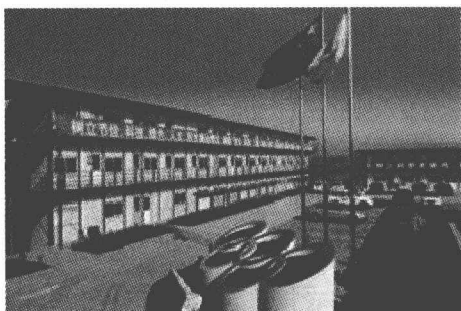
(a) 北京城建集团奥运村项目部
