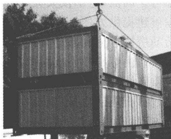
(b) 新型箱式集成房拆分单元吊装
