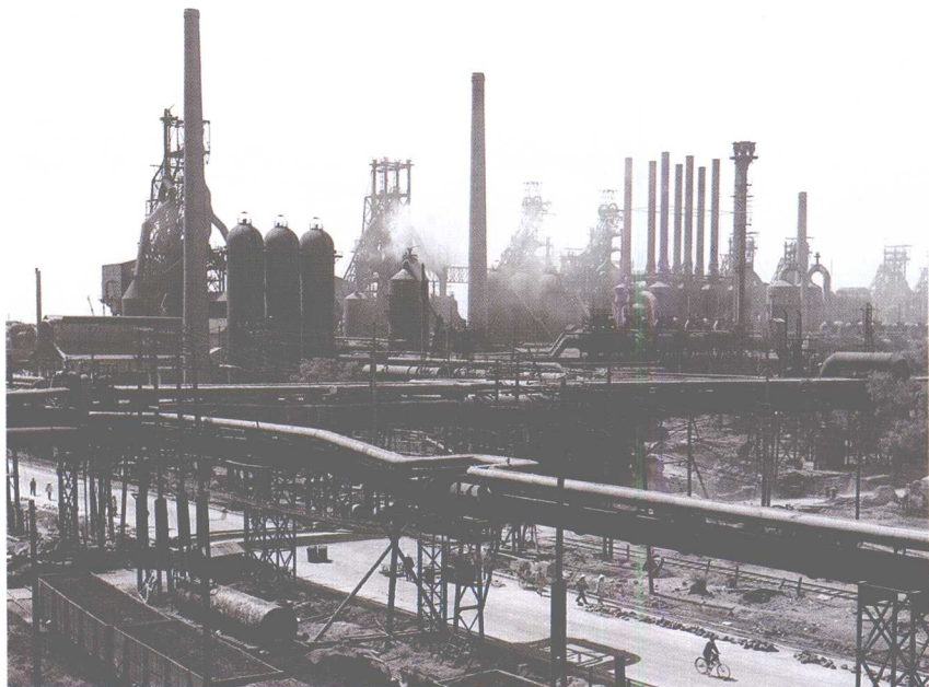
“一五”计划时期，以鞍山钢铁公司为中心的东北工业基地在社会主义工业化建设中发挥了重要作用。图为鞍钢外景。
