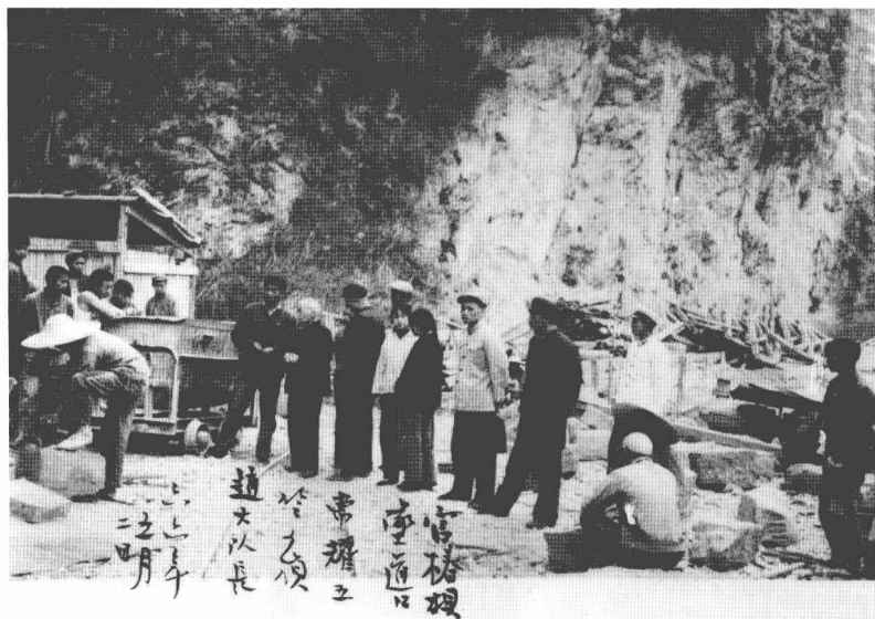
参观成昆铁路 官椿坝隧道， 竺可桢（翻斗 车旁右 2）在 听取施工队长 的讲解（1966 年 5 月 2 日）
