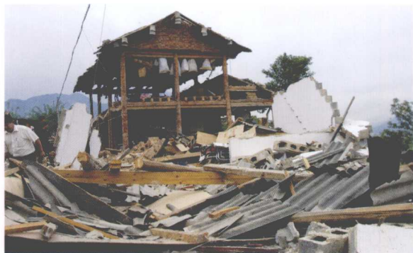
宁洱县新平村房屋倒塌严重
