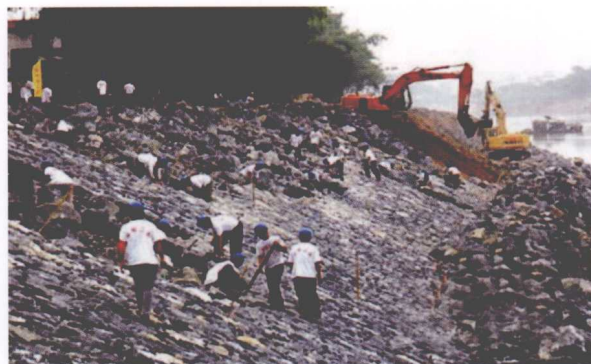
广东省台山市抓紧修复水毁工程
