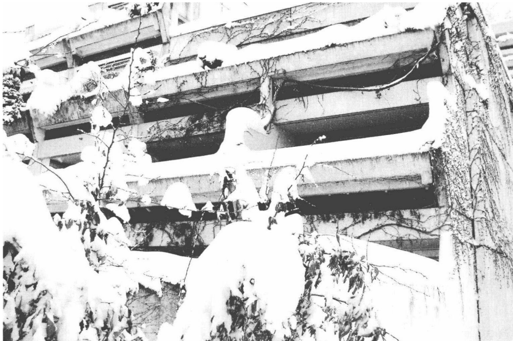
上图：Connollystrasse 31号的后面。人质当时被囚禁在二楼右后方的房间内。
