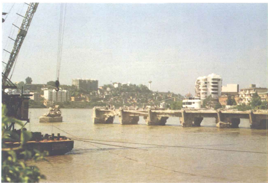
正在拆除的解放大桥（1995年）
