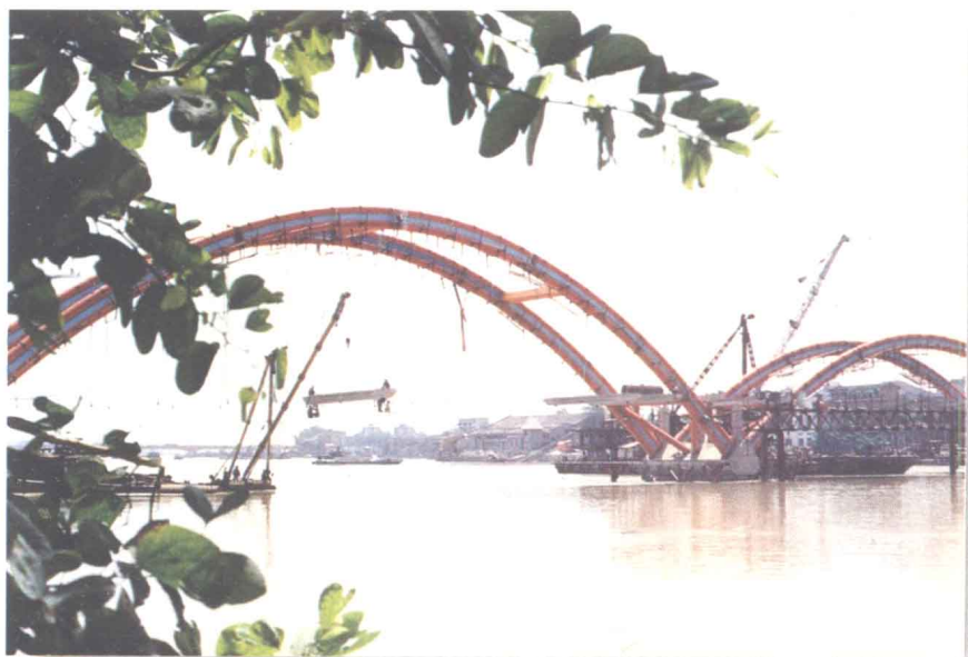
正在吊装新建解放大桥 最大拱桥桥面的横梁（1996年8月）
