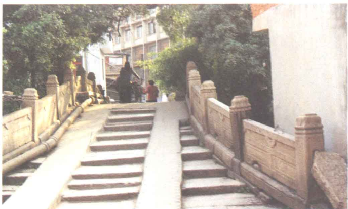
桥面现状（南端）
