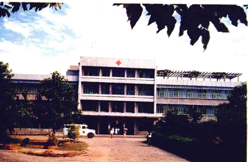
◀县一医院门诊大楼
