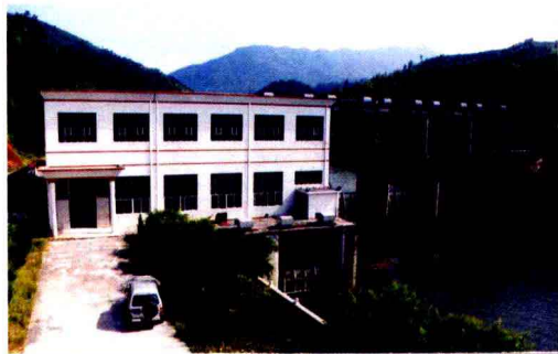
装机容量2500千瓦的旺龙水电站
