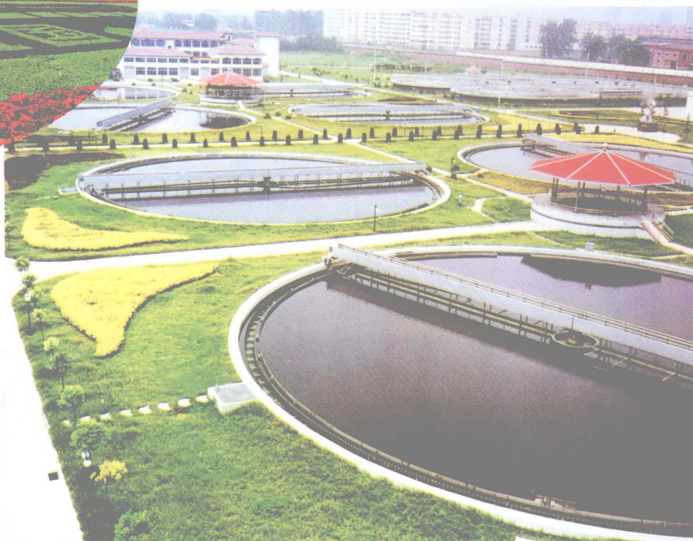
△ 区上阳路南端的污水处理厂
