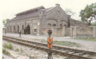
(车辆维修车间)
