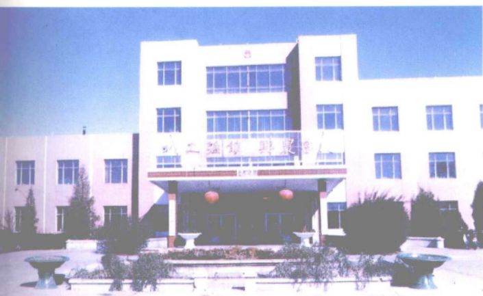
五间房镇政府办公楼
