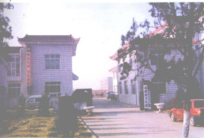
市卫生局办公楼
