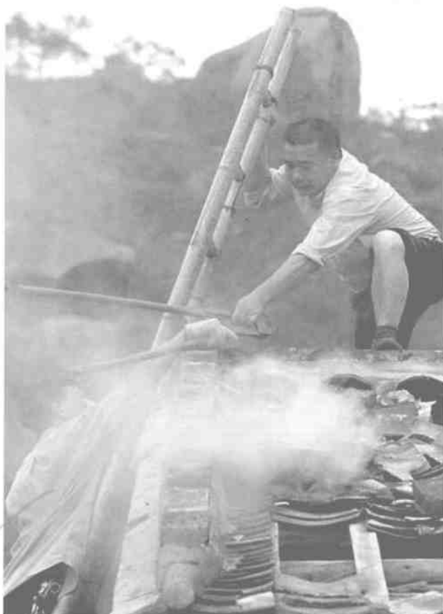
深圳灾区村民正在修补被台风破坏的屋顶。
