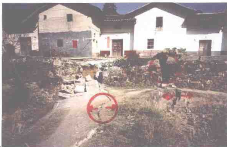
塌陷现场之一。
