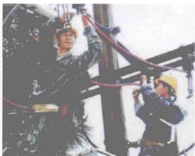
电力工人在抢修输电线路。
