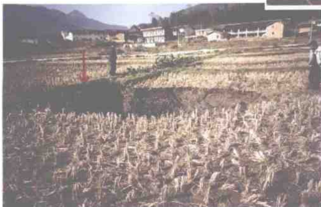
塌陷现场之二。
