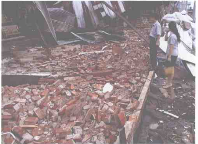
顺德区一倒塌的厂房。
