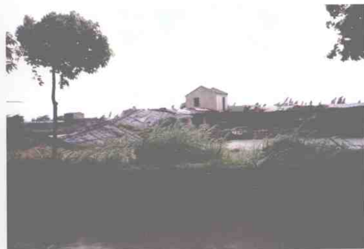
顺德区部分房屋倒塌。
