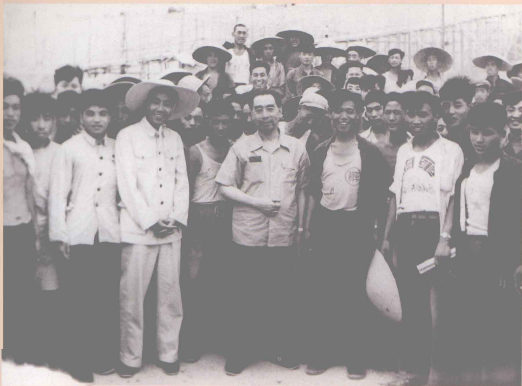
1958年6月26日周恩来总理视察怀柔水库建设工地
