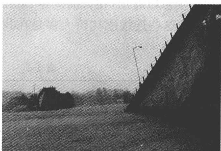
图 1-1 帕劳共和国 Koror-Babeldaob 桥在加固后倒塌
