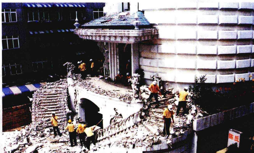
大型违章建筑『金色大世界』被依法拆除 (彭年 摄)
