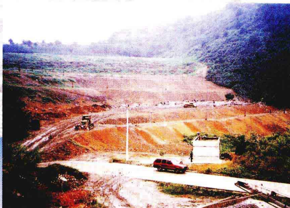
仙人脚生活垃圾卫生填埋场
