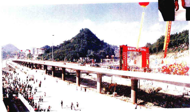
三桥立交桥竣工通车
