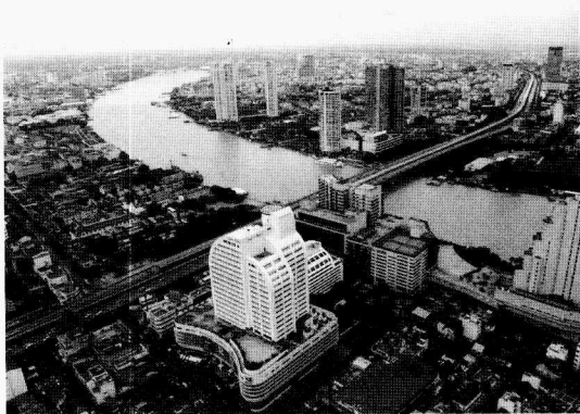
图 1-5 曼谷高架轨道线路 [3]
