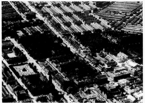
图 1-3 19 世纪工业城市高密度的建筑区块 [5]
