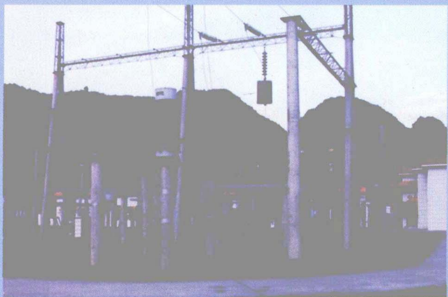
1997年12月岩滩到凤山110千伏安高压输电线路及变电工程竣工送电，改变了凤山电力严重不足的状况。
