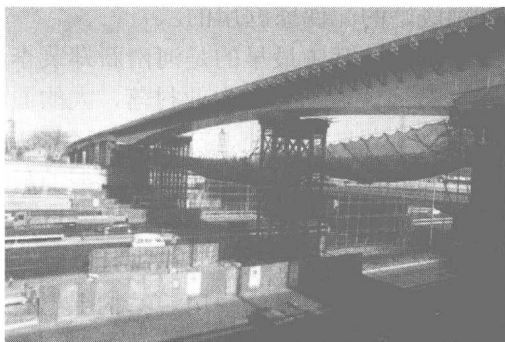
图 1-43 城市轻轨建筑
