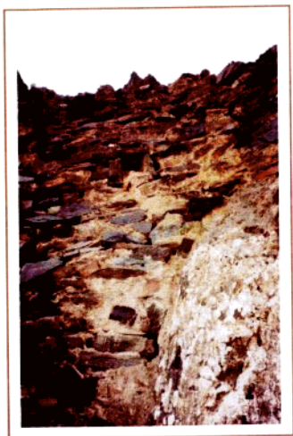
沙湾沟堵塞豁口长城连山带河
