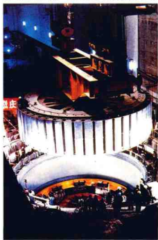
中国青海龙羊峡水电站水轮发电机组吊装
