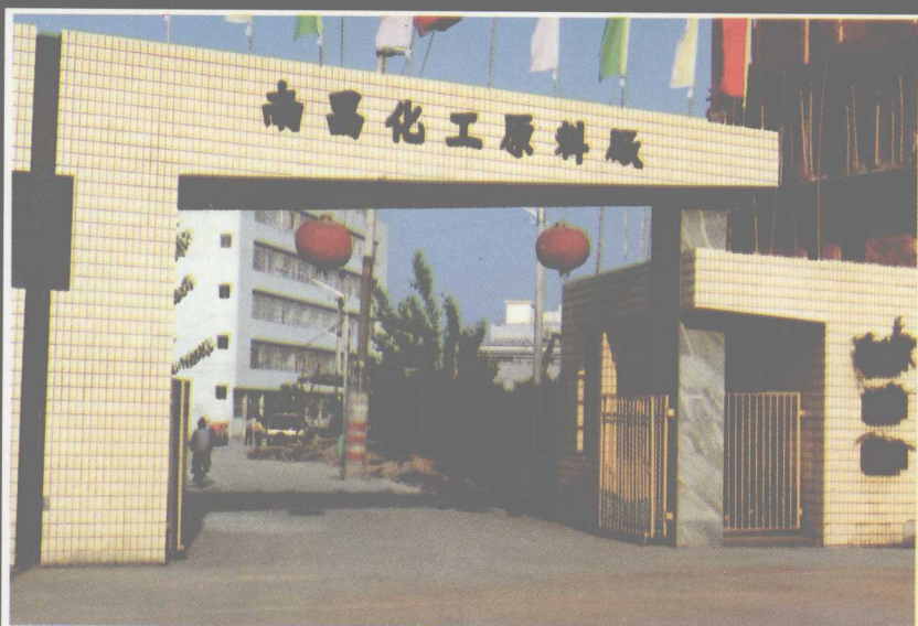
南昌化工原料厂外景
