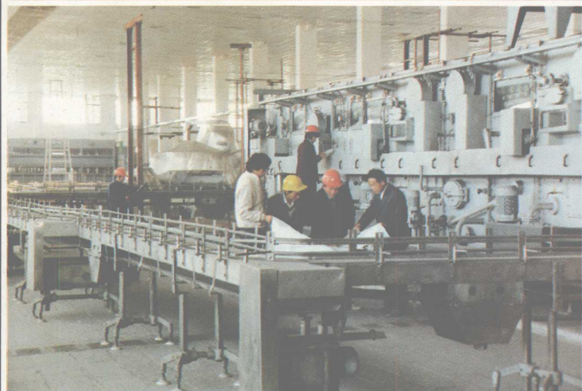
南昌罐头啤酒厂5 万吨啤酒扩建工程 正在紧张施工中
