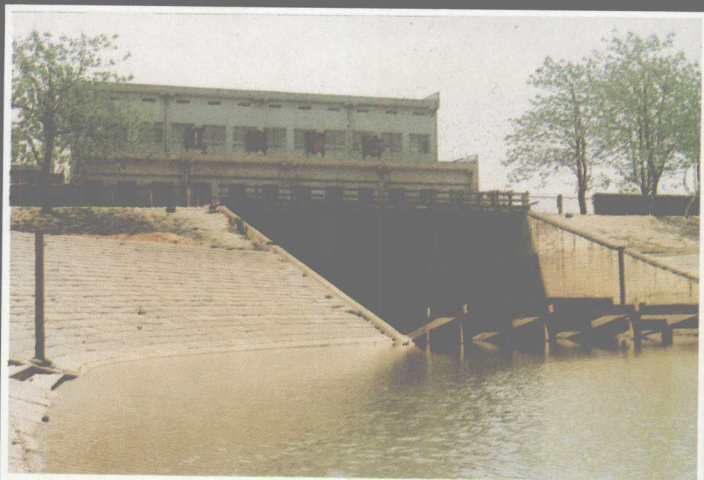
南昌县红旗联圩排涝 工程：红旗大泵站
