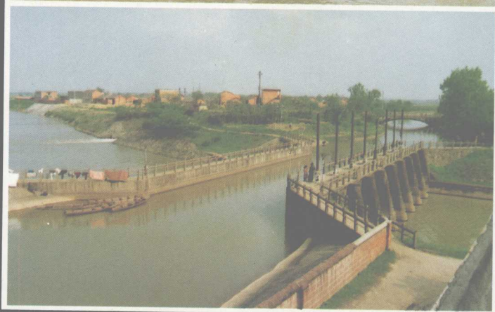
赣抚平原水利工 程中的莲塘渡槽
