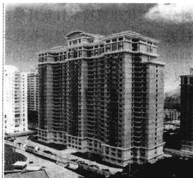
图 1.8 剪力墙结构:高层住宅楼
