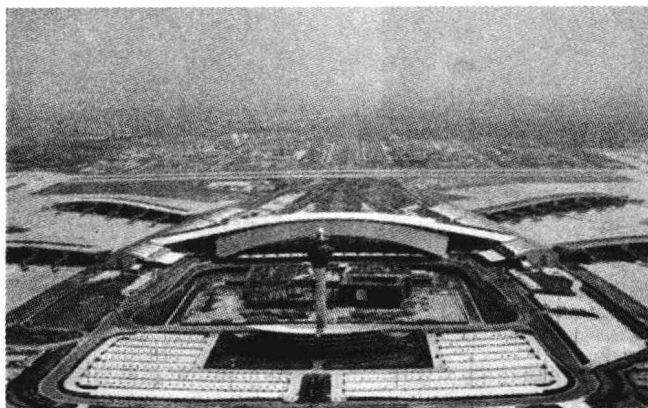
图 1.13 立体桁架结构:广州新白云机场
