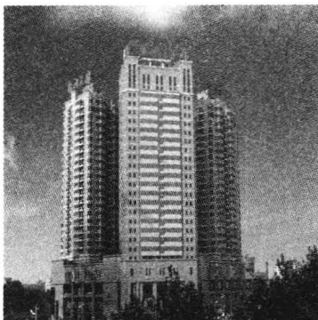
图 1.9 框支剪力墙结构:商住楼
