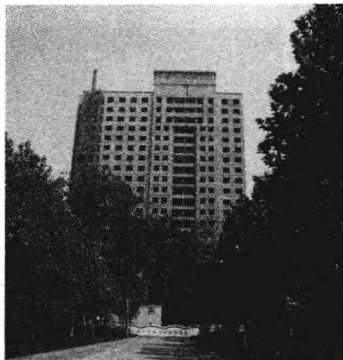
图 1.10 框架剪力墙结构:写字楼
