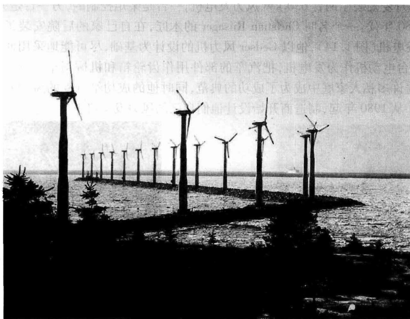
图 1.17 Nortank 55 kW 风力发电机
