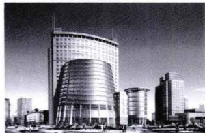
图1-4 某大型购物商场外观
