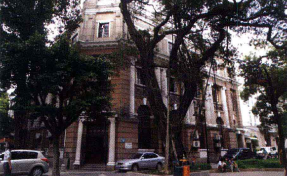
广州沙面渣打 银行旧址
