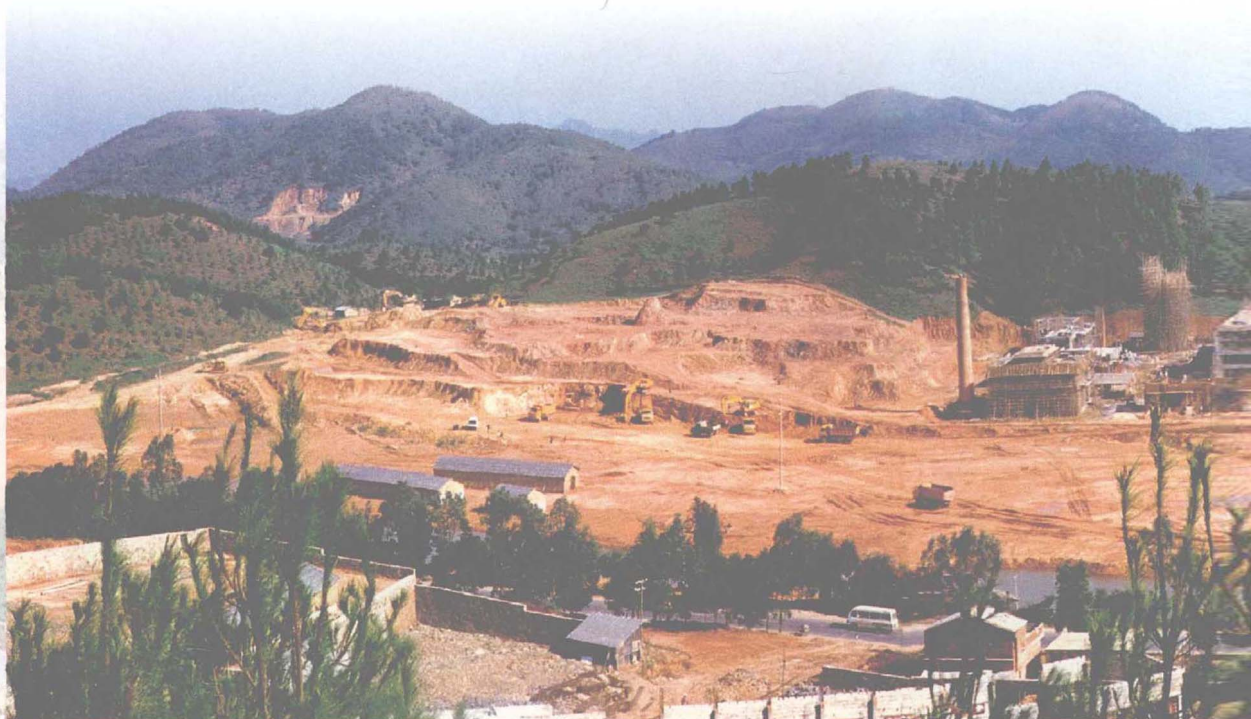
阳东建区时期，建设大令工业开发区
