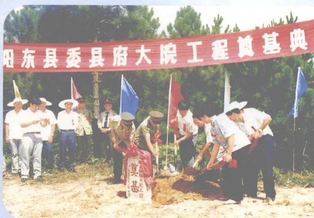
1991年7月1日，阳东县委、县政府大院工程奠基
