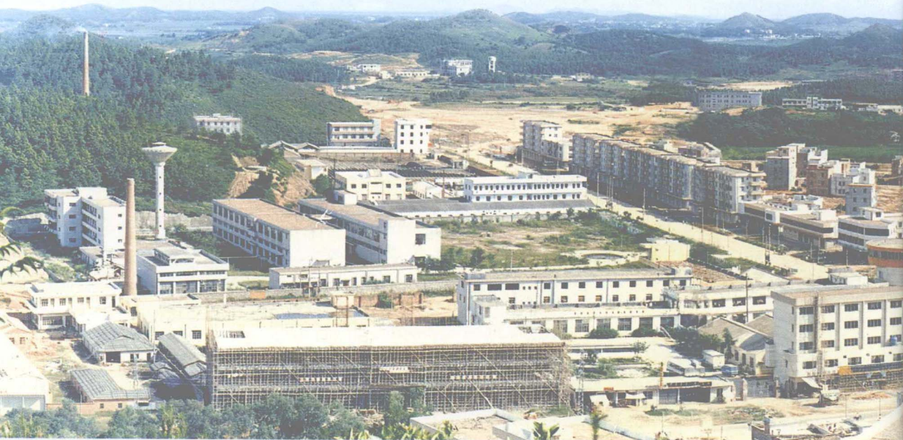
建设初期的阳东县城
