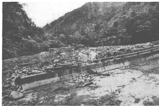
图1.10 四川省汶川县映秀牛圈沟泥石流淤埋公路,中断交通
