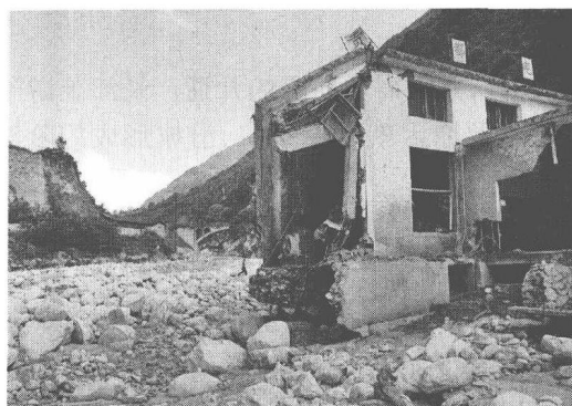
图 1.13 被泥石流冲毁的水电站(四川泸定,陈晓清摄)
