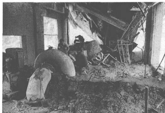
图 1.13 被泥石流冲毁的水电站(四川泸定,陈晓清摄)
