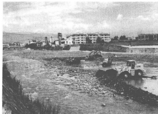
图 1.1 四川省西昌市被泥石流毁坏的河堤以及河道遭泥石流淤积而被迫人工清淤
