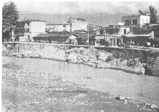
图 1.1 四川省西昌市被泥石流毁坏的河堤以及河道遭泥石流淤积而被迫人工清淤
