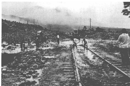
图 1.7 泥石流淤埋成昆铁路蒲坝车站(1995 年)
