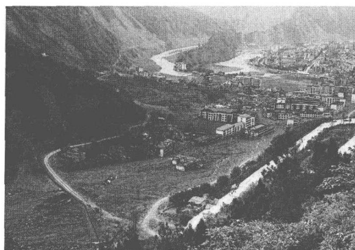
图 1.4 四川省北川县老县城遭泥石流淤埋
