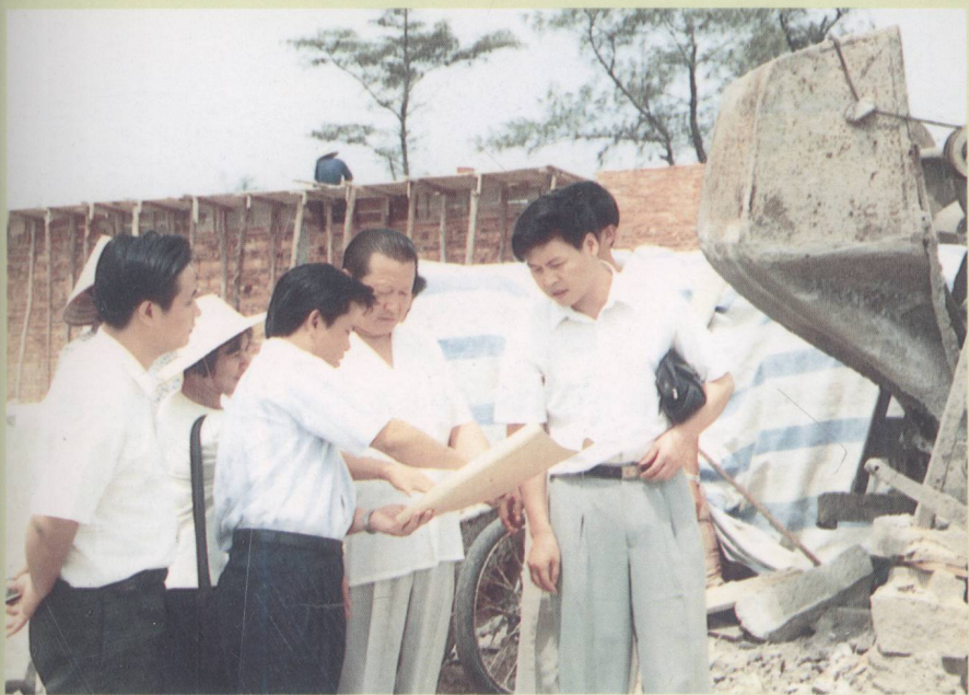
▲刘学斌察看临高角“解放海南纪念园”工地。图为临高县委书记许俊(右三)、团省委副书记叶章和(右一)、王琼珠(右四)向刘学斌(右二)汇报施工情况。
