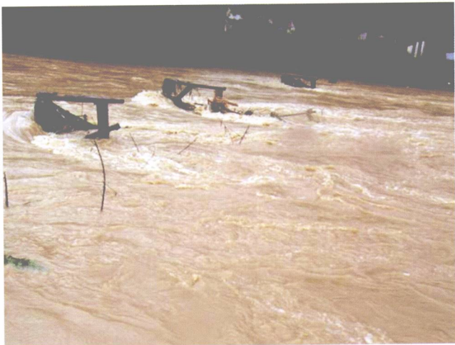
云浮市木桥被洪水冲垮。（省气象局提供）
