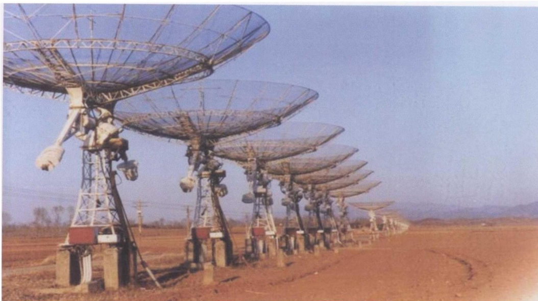
由 28 面 9 米天线组成的密云米波综合孔径射电望远镜（1984—1999 年）
