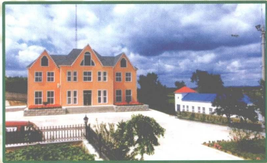
石佛寺灌区渠首站
