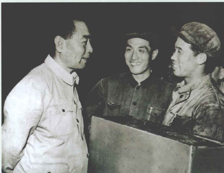
1956年3月国务院总理周恩来视察鞍钢无缝钢管厂
