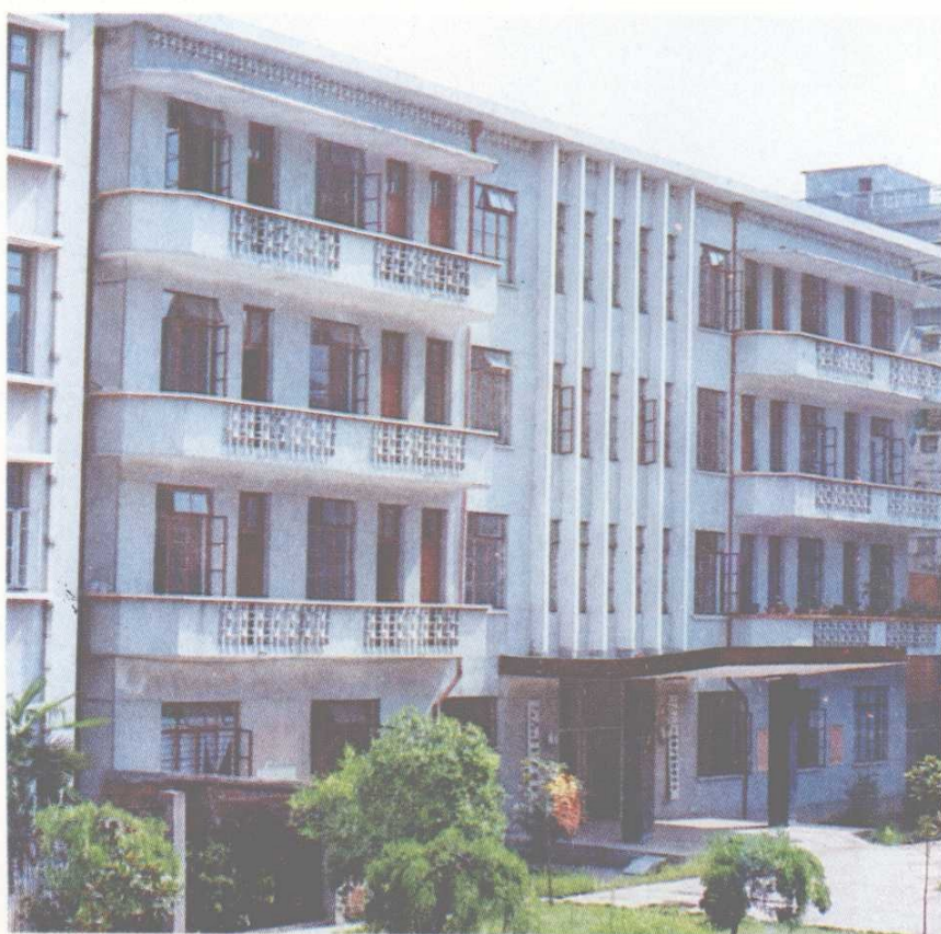
人大常委会 弋阳县人民政协办公楼
