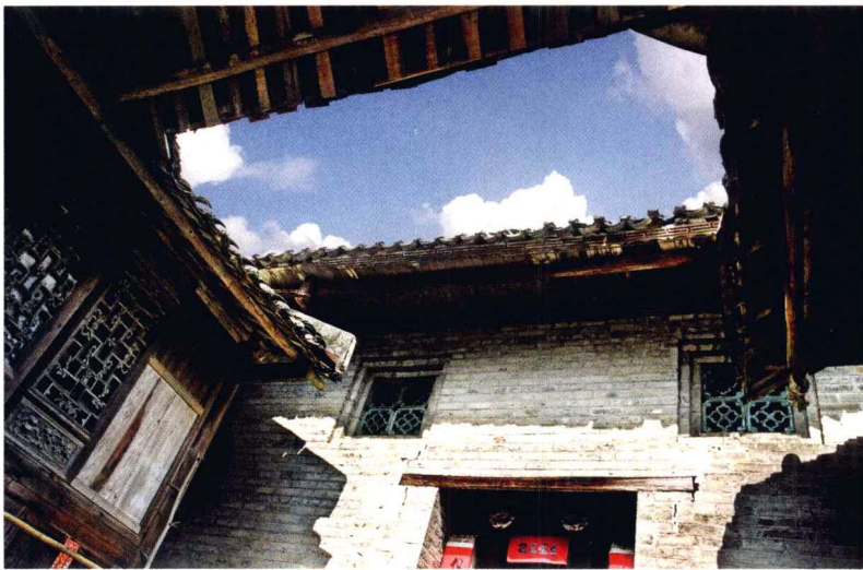
(8) (9) 保留着中国传统建筑的布局 and 风格，秦砖汉瓦、木柱木梁的阳朔渔村古民居。
