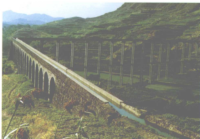
大石乡莲花山渡槽
