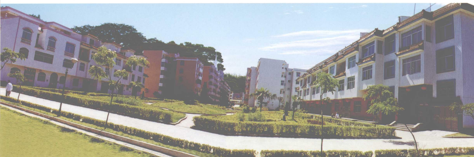
白鹤园住宅区
